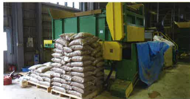
木質バイオマス製造施設
